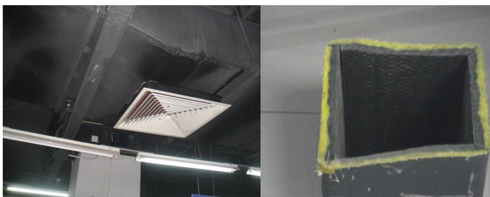
图 3-1 某项目玻纤风管使用 9 年后外观
