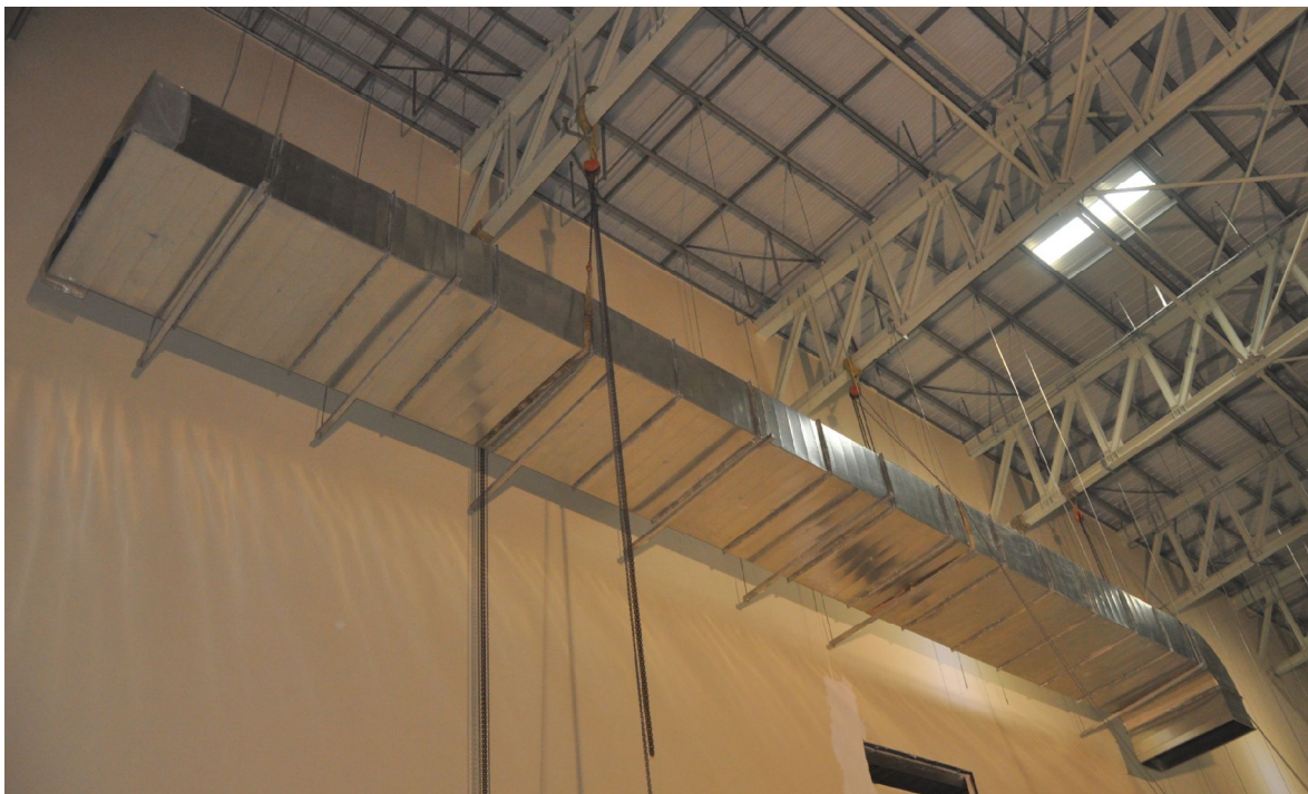
图 5.2.8-2 手动葫芦吊升风管
