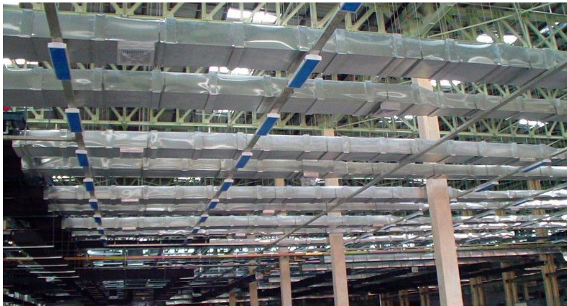
图 5.2.8 安装及调整完成后观感图
