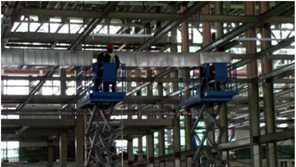
图 5.2.8-1 垂直升降车吊升风管
