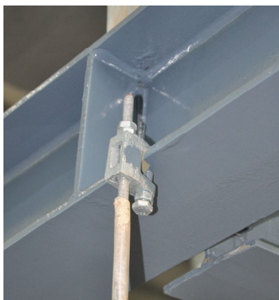
专用钢结构夹具加吊杆方式
