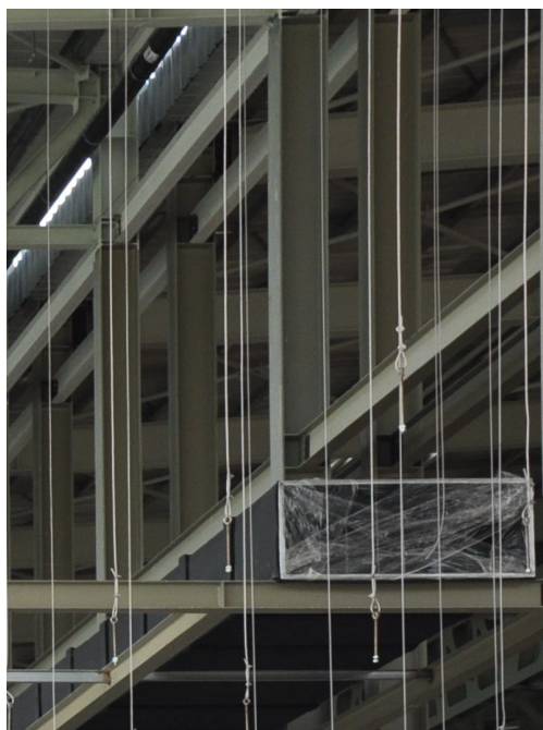
图 7.3.8 开口端包上薄膜，防止灰尘等污染风管内部
