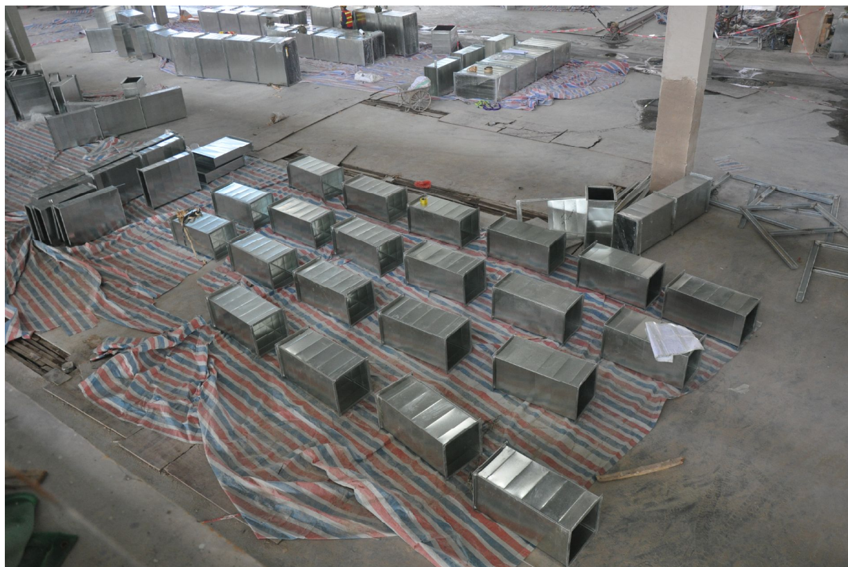
图 7.3.7 地面风管组对连接时在地面铺设保护膜保护
