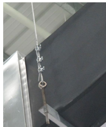
钢丝绳悬吊安装方式
